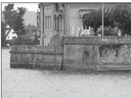
Die seeseitige Mauer des Schlosses wurde zuletzt 2008 mit Kernbohrungen und großem Aufwand inspiziert; eine Spezialfirma soll nun genauer feststellen, wovon bei möglichen Sanierungen mittel- und langfristig ausgegangen werden muss. Bild: tv
