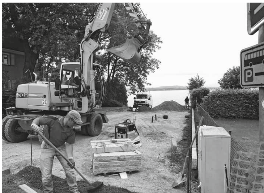
An der Friedrichshafener Straße/Ecke Untere Seestraße wird derzeit die erste Willkommensinsel samt Fahrradabstellplätzen in Langenargen gebaut. Bild: ah
