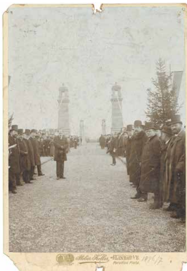
Atelier Keller, Lindau: Einweihung der Kabelhängebrücke über die Argen am 25. Januar 1898 Fotografie: Museum Langenargen
