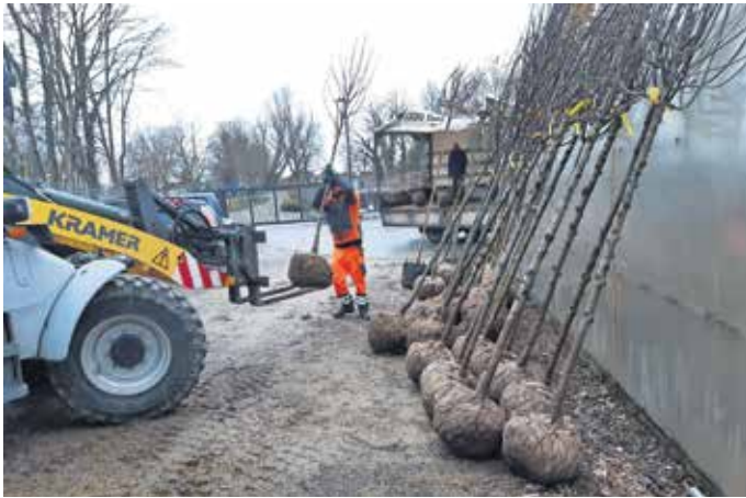
Die ersten 30 Bäume kommen beim Bauhof an.
