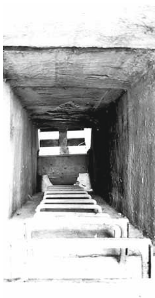
Einblick durch den Schacht in die Ankerkammer der Kabelhängebrücke, in dessen Tiefe die Enden der tragenden Kabel einbetoniert sind.
