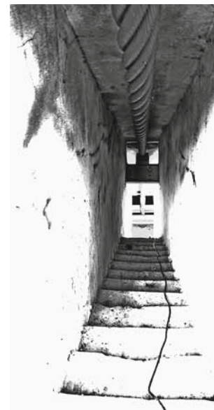
Seltener Anblick – den Rest des Jahres geschlossen: Der Wartungseingang in die Ankerkammer, die das Kabel von den Pylonen aufnimmt.
