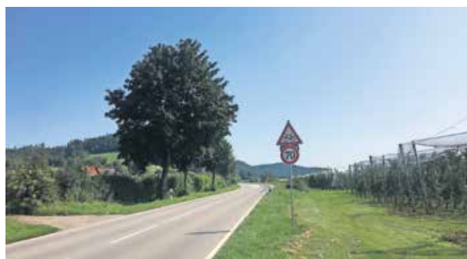
Im Querungsbereich des Radweges Mückle-Gießenbrücke gilt nun Tempo 70, eine Verkehrsinsel wird in Kürze eingebaut. Bild: Gemeinde Langenargen
