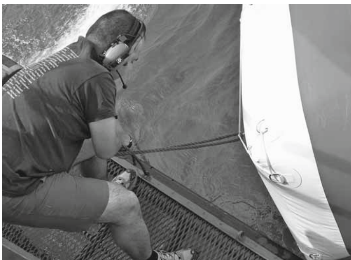
Maximaler Abstand zum Ufer, hier drei bis vier Meter Tiefe. Die Bojen dürfen nicht zu stramm am Ankerstein befestigt sein, sonst können sie von Wellen angehoben werden und abtreiben. Sind sie zu locker, können die Ankersteine über Grund wandern.
