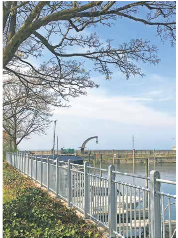
Das Geländer am Hafen (Absturzsicherung).
