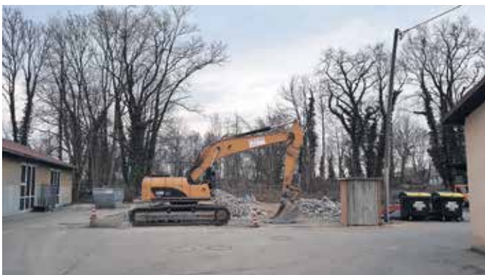
Standort Bauhof-Fahrzeughalle (Feuerwehrprovisorium).
