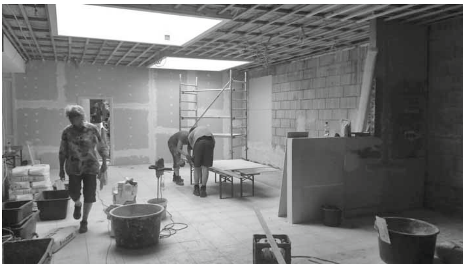
So sah die Baustelle noch im Juni aus: Ortsgruppenleiterin Beate Fuchs beim Inspizieren des Materials. Es warten noch jede Menge Gips, Mörtel, Estrich und Farbe darauf, verarbeitet zu werden. Feste am Schaffen sind Martina Maier, Matthias Janisch und Jan Krüger. Bilder: Matthias Janisch
