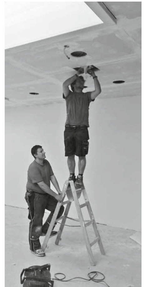
Fortschritte im Juli: Wand und Decke sind fast fertig. Markus Franke und Alexander Jäger montieren die Beamer-Halterung in dem künftigen Schulungsraum.
